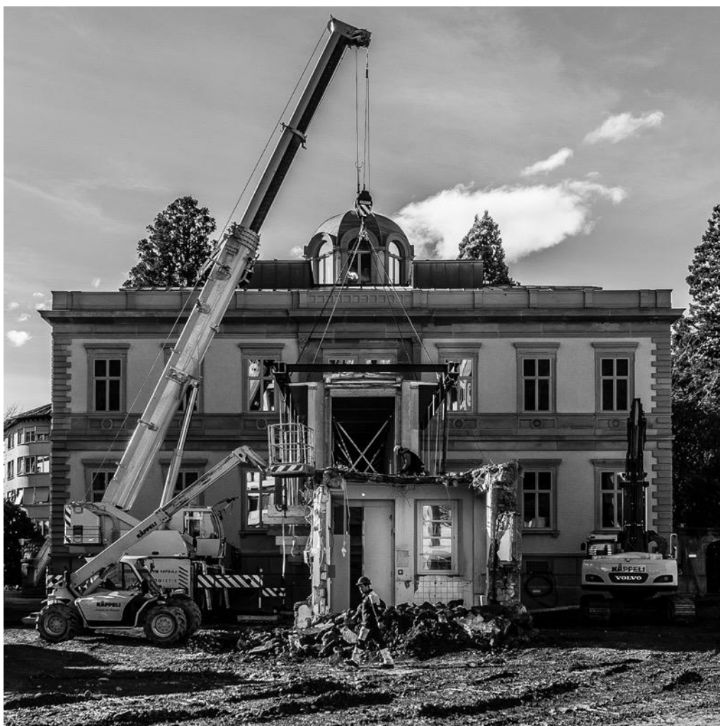
Erweiterung Kunstmuseum Chur, Abtransport der ausgedienten Passerelle des Architekten Peter Zumthor
